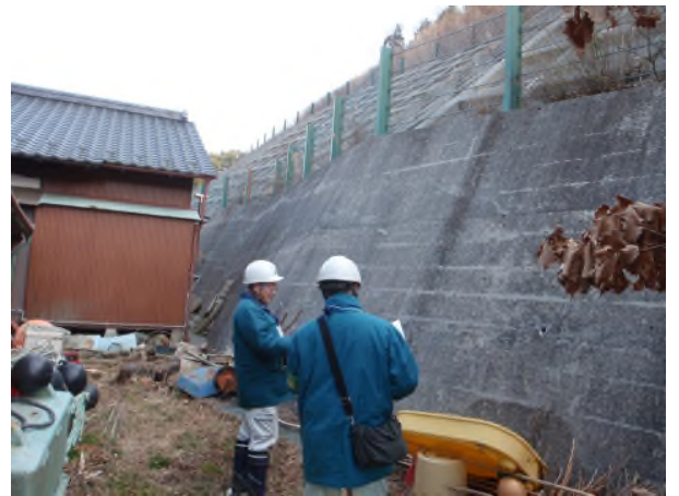
砂防設備の点検状況 (岩手県大船渡市)
