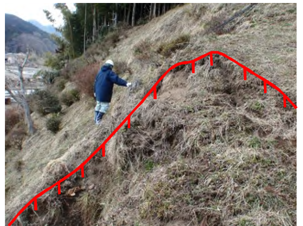
地すべり発生箇所の点検状況 (岩手県陸前高田市)
