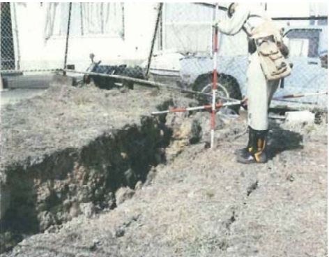
地震によって地盤が脆弱になっている様子
