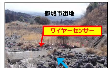
ワイヤセンサーによる工事中の安全監視
