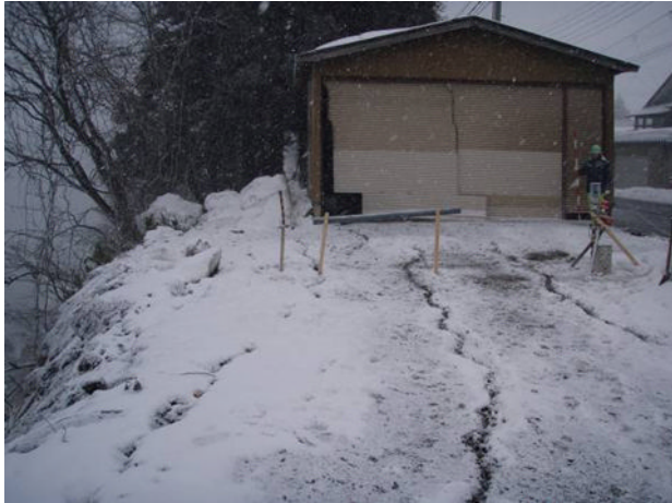
つなん しょうめん 新潟県津南町正面（伸縮計、警報機設置）
