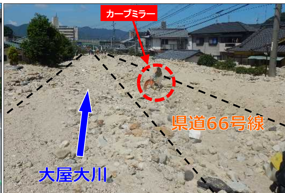
被災後状況写真
