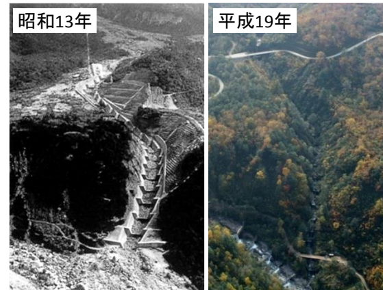
泥谷堰堤(昭和13年竣工)
