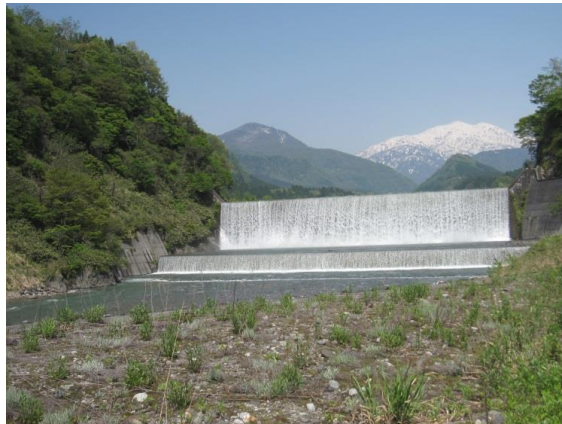
本宮堰堤(昭和11年竣工)
