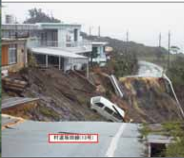
地すべり斜面上部の住宅被災状況
