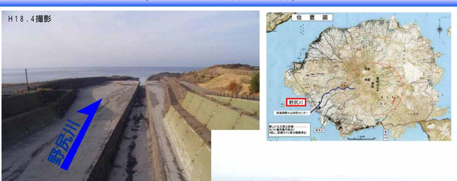
今回の一連の土石流により、約3万7,000 m<sup>3</sup>の土砂が流路内に堆積しています。
