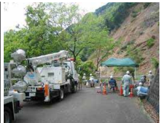
写真③ 監視状況 (H18.5.14撮影)
