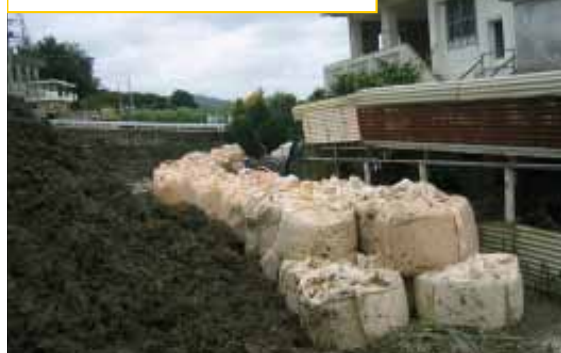
大型土のうによる応急対策
