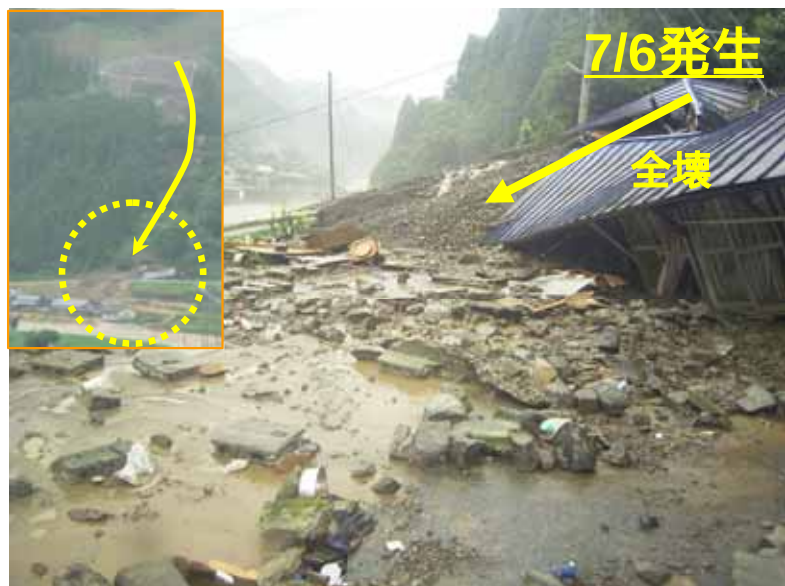
かみましきぐん やまとまち こうまちく ↑ 熊本県 上益城郡 山都町 甲馬 (家屋全壊1戸 避難により人的被害なし)
