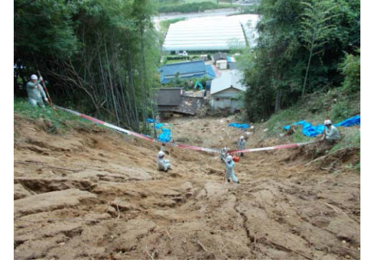
② 斜面状況
