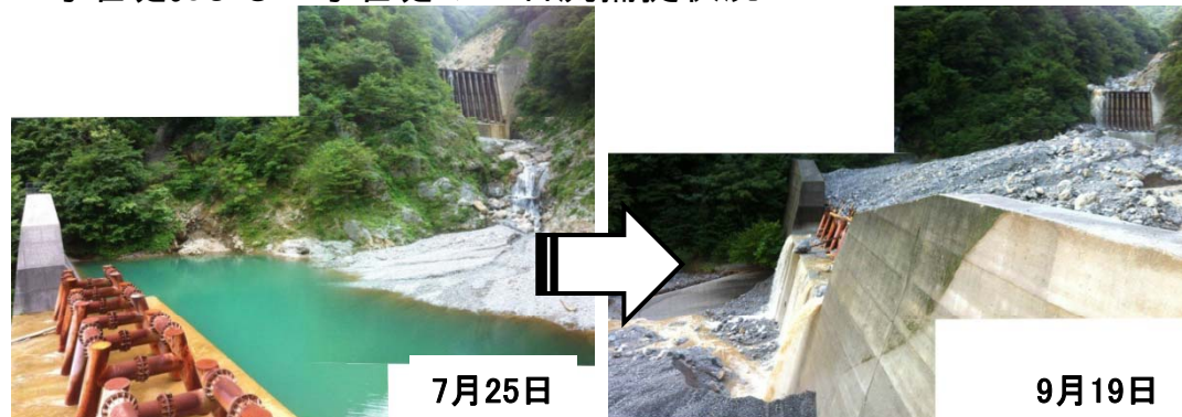
1号堰堤の土石流捕捉状況
