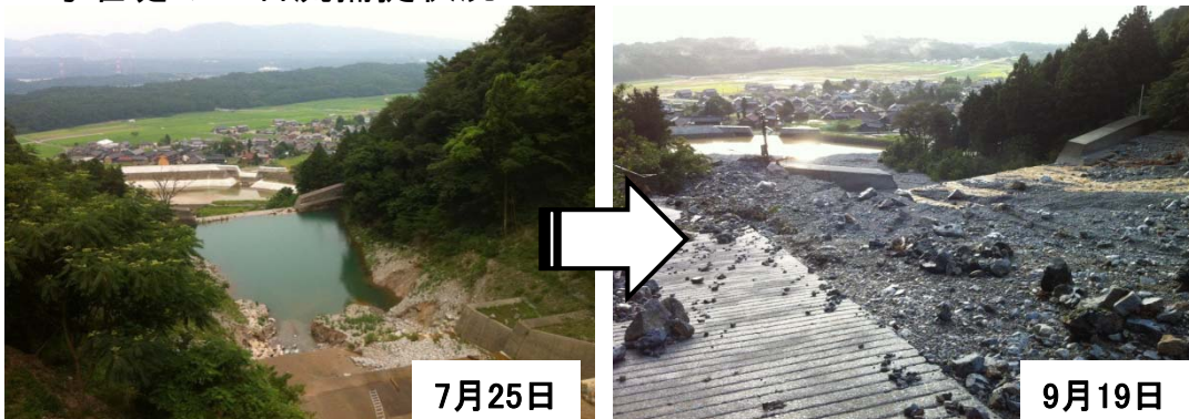
1号堰堤の土石流捕捉状況
