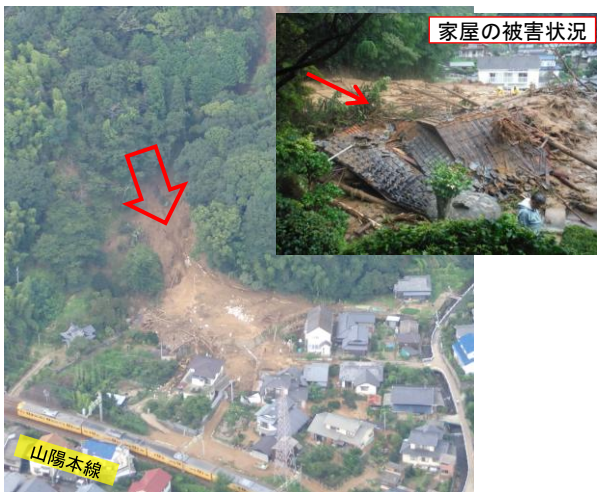
8/6 がけ崩れ発生【岩国市新港町】
