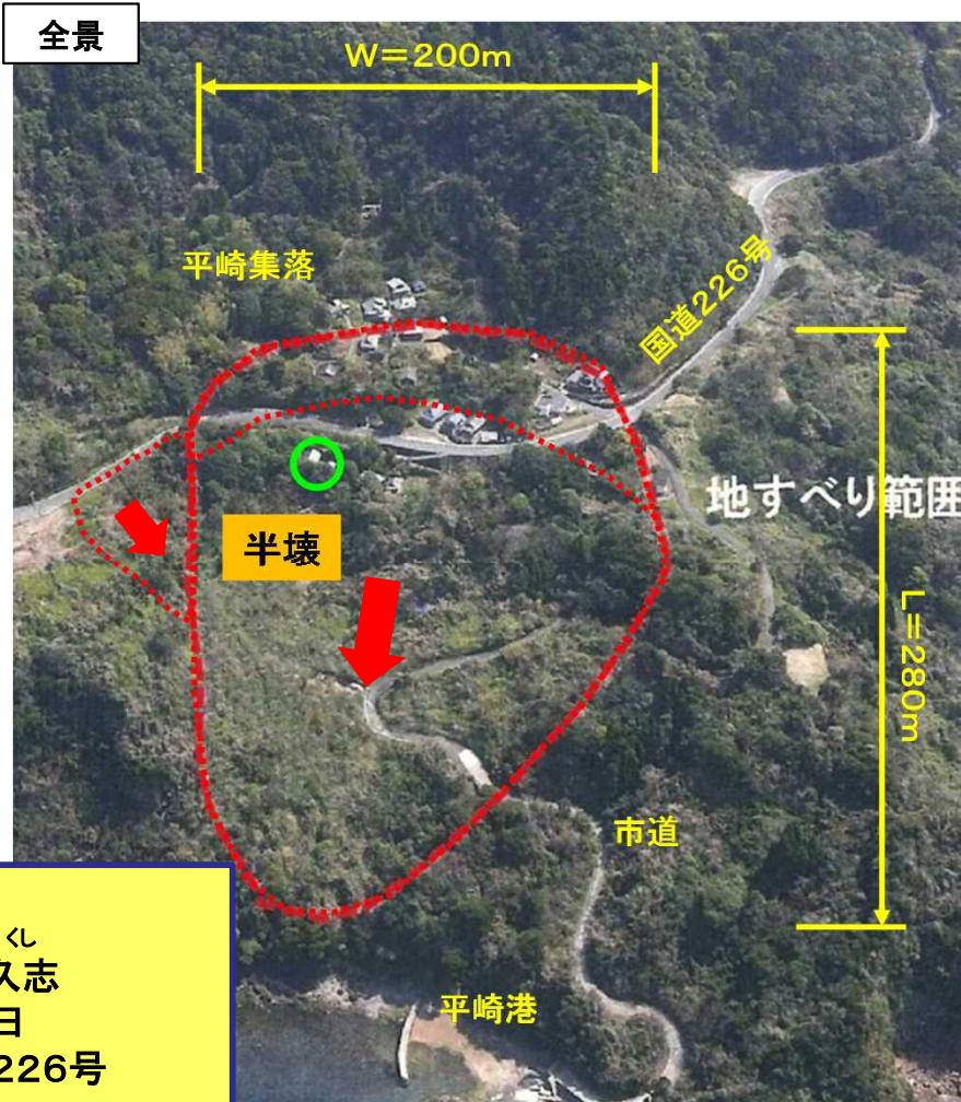
市道 被災状況
