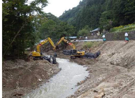
大型土のうによる応急復旧状況
