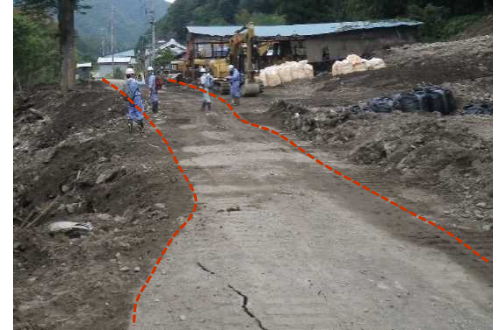
復旧された道路
