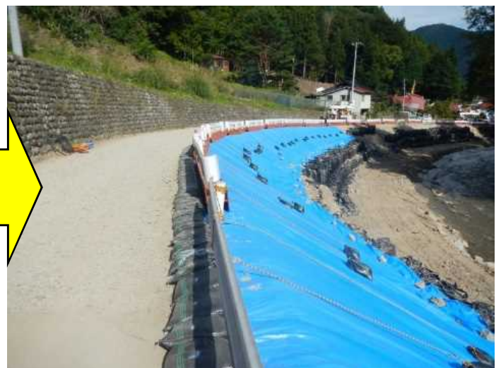
応急復旧完了状況
