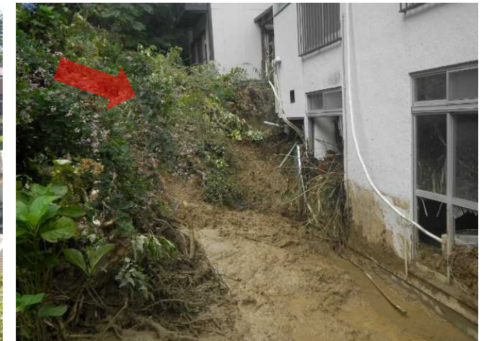
③家屋の被害状況
