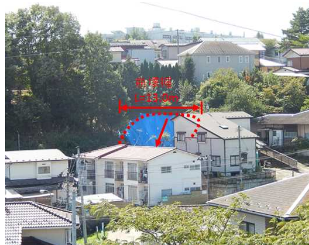
②斜面崩落全体状況
