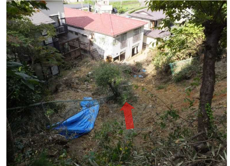
①斜面の崩落状況
