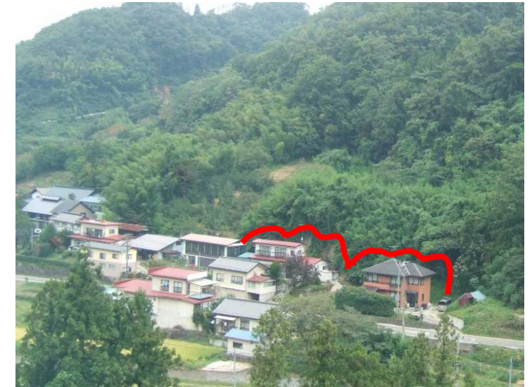
①斜面崩落全体状況
