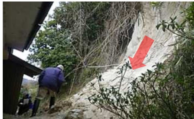
②斜面崩落状況
