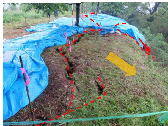
②斜面の亀裂状況
