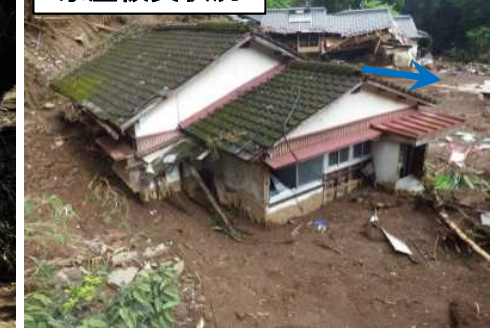
家屋被災状況
