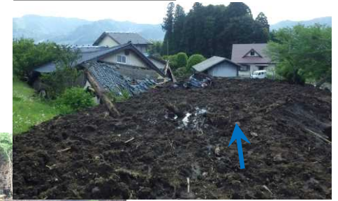
家屋被災状況
