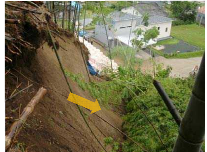
②斜面崩壊状況(その2地区)
