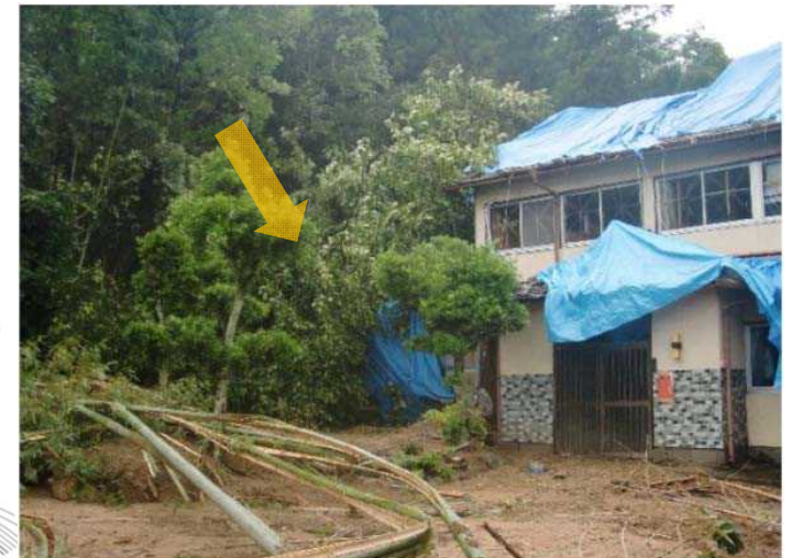
②斜面崩壊状況(その2地区)
