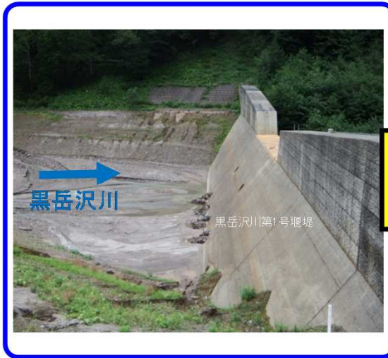
土石流発生前 (H27.8.20撮影)
