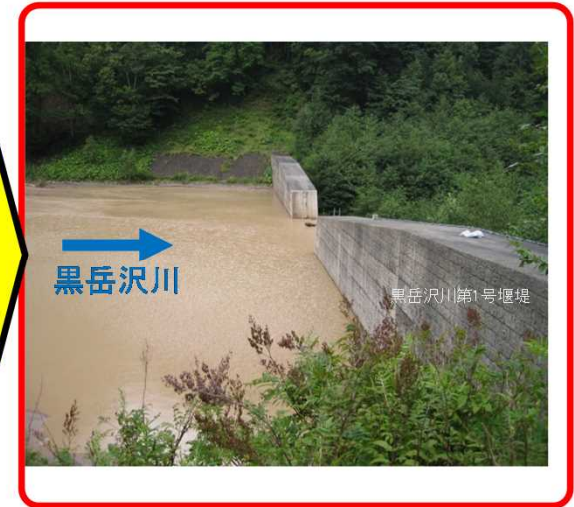
土石流発生直後 (H28.8.23撮影)
