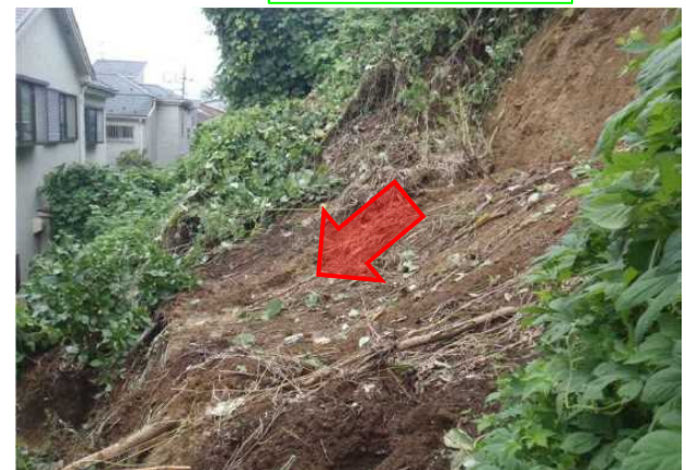
8/22 がけ崩れ いたばしく にしだい 東京都板橋区西台
