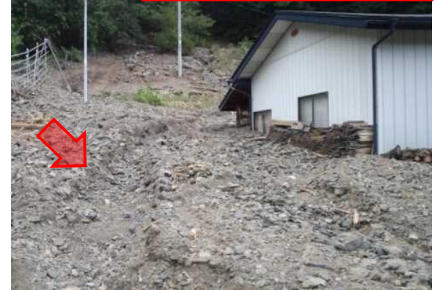
8/30 土石流等 しもへいぐんいわいずみちようあさない 岩手県下閉伊郡岩泉町浅内
