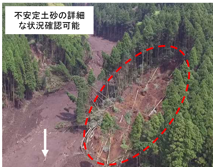
山腹崩壊の状況 (撮影4/19 山王谷川地区)
