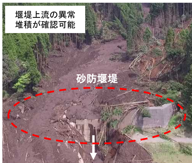
堰堤上流の堆積状況 (撮影4/19 山王谷川地区)
