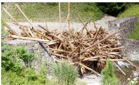
流木捕捉工(兵庫県宍粟市)
