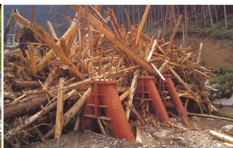
流木捕捉工(大分県中津市)
