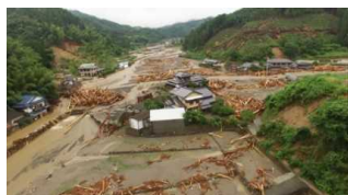
赤谷川における土砂・流木被害
