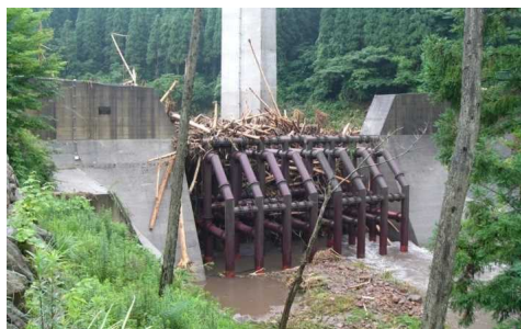
透過型砂防堰堤(熊本県小国町)
