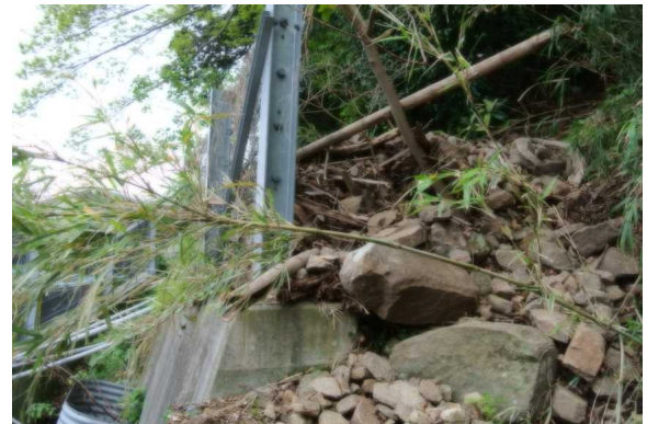
がけ崩れ発生直後 (H29.4.21)
