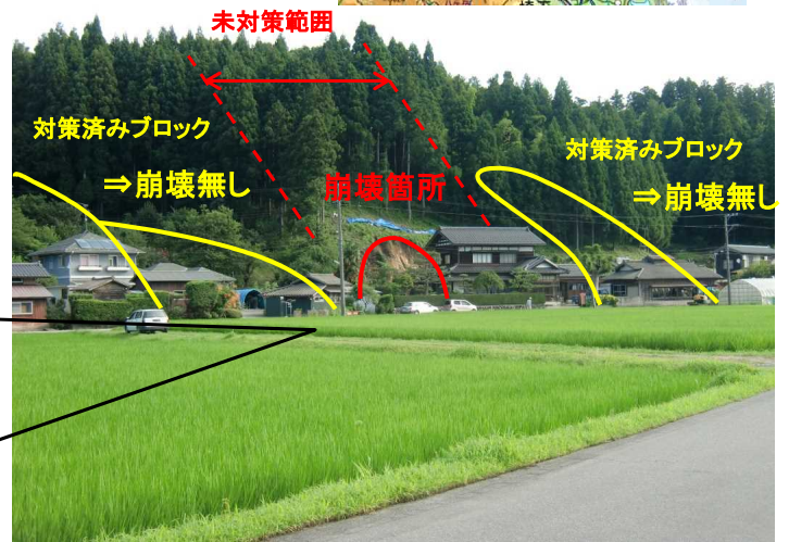
崩壊箇所と周辺状況
