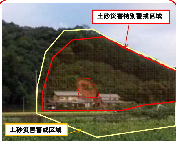
がけ崩れ発生直後(H29.10.23)
