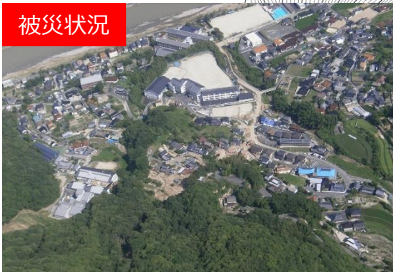
土砂堆積状況
