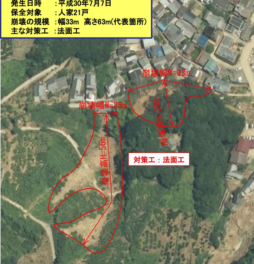
①斜面崩壊状況
