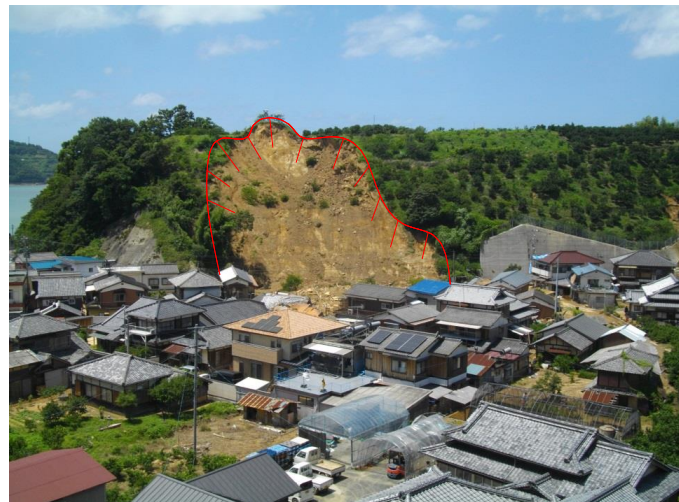
①斜面崩壊状況
