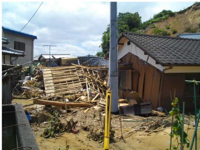
②被害状況
