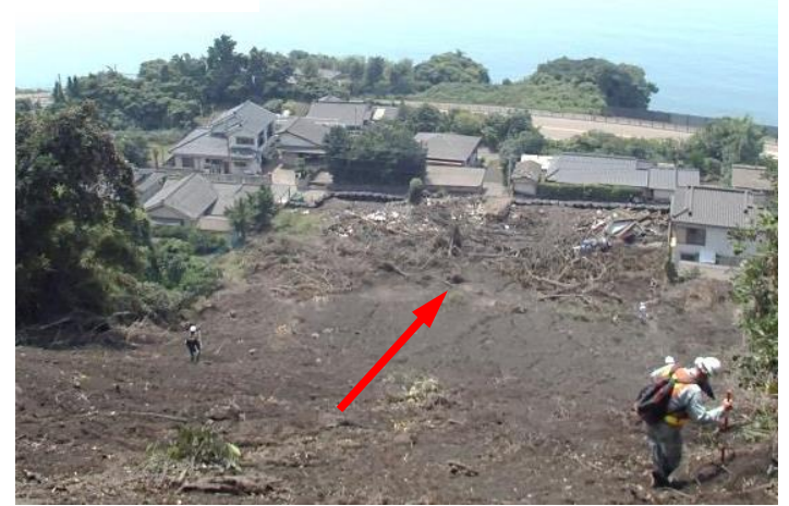
①斜面崩壊状況
