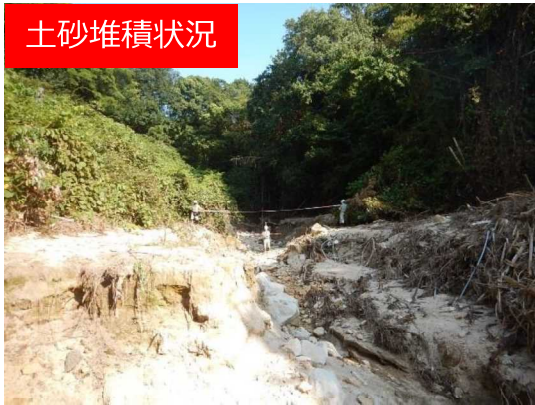
土砂堆積状況
