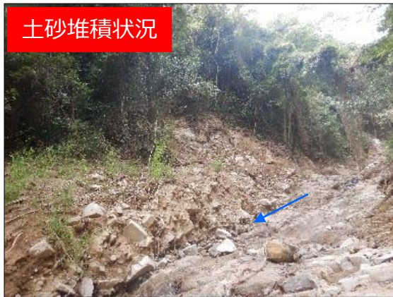
土砂堆積状況
