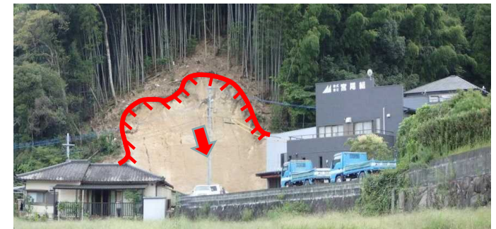
斜面崩壊状況
