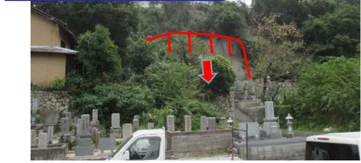
斜面崩壊状況
