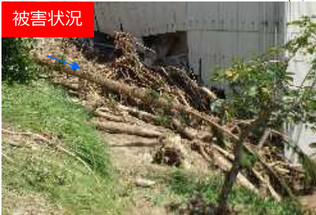
土砂流出状況
