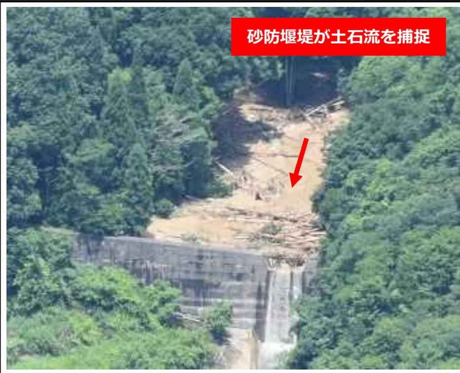
砂防堰堤が土石流を捕捉
