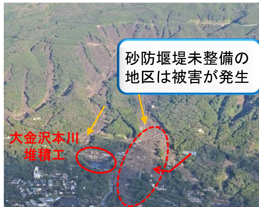
おおしま かんだつ 大島町神達地区の被害状況
