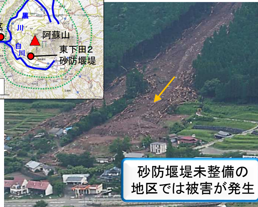
みなみあそ たての 南阿蘇村立野地区の被害状況
