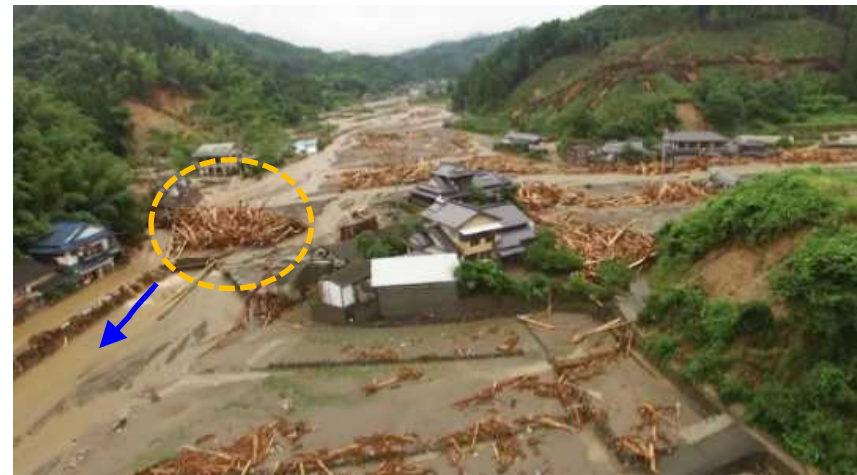
流木の橋梁閉塞による氾濫被害(赤谷川)
