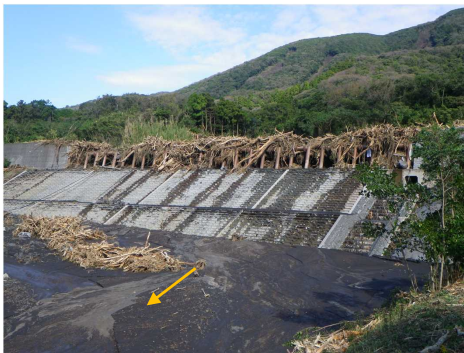
土石流・流木の捕捉状況 おおがねさわ (大金沢本川堆積工) (高さ3.0m、長さ105.8m)
