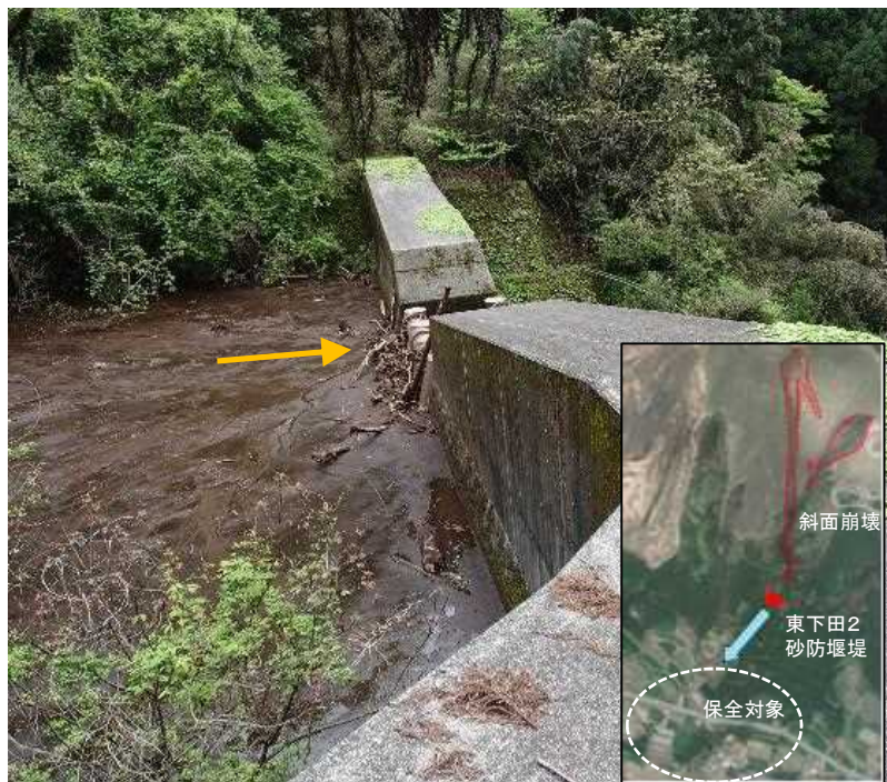
土石流の捕捉状況 ひがししもだ (東下田2砂防堰堤) (高さ8.5m、長さ58.7m)
