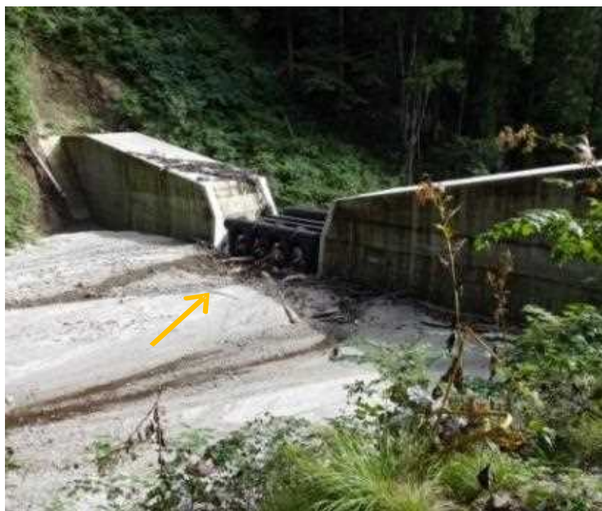
土石流の捕捉状況 たもさわ (田茂沢第1砂防堰堤) (高さ12.5m、長さ43.0m)
