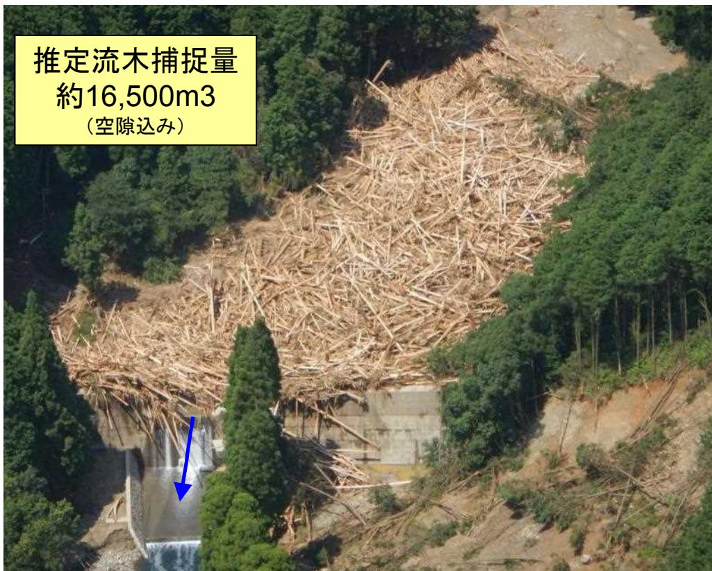
流木の捕捉状況 すがわ (須川第1砂防堰堤) (高さ7.0m、長さ74.8m)
