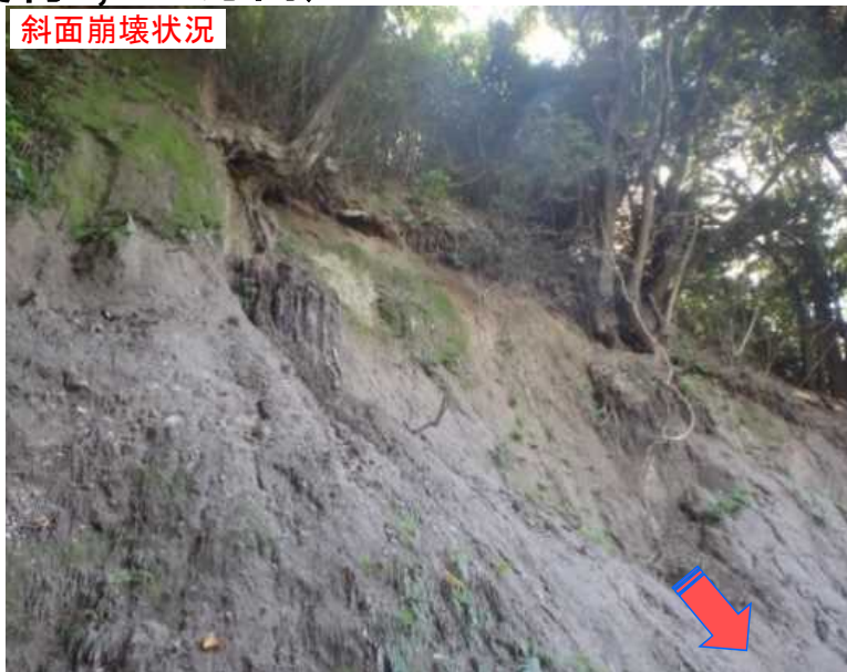
斜面崩壊状況
