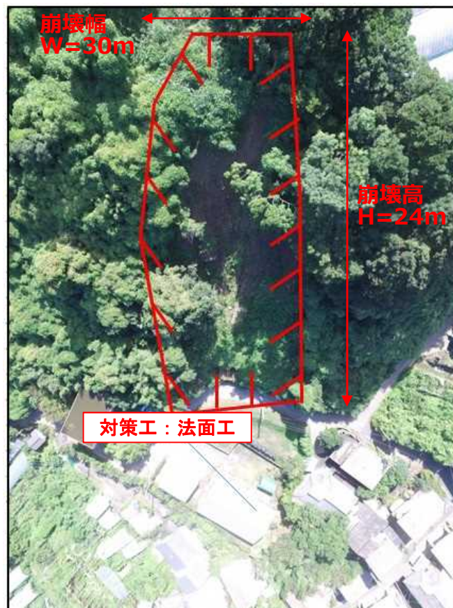
斜面崩壊状況
