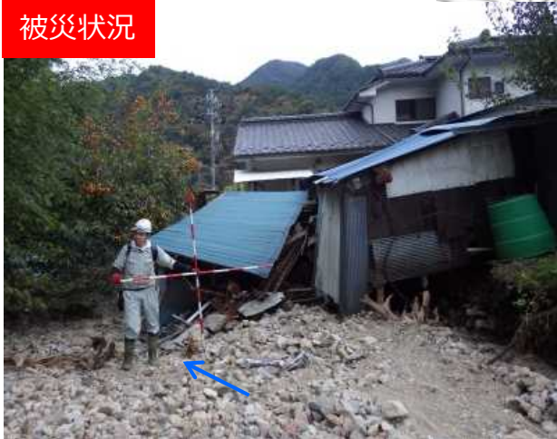
不安定土砂堆積状況
