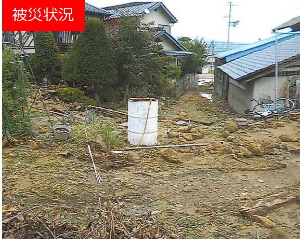
不安定土砂堆積状況
