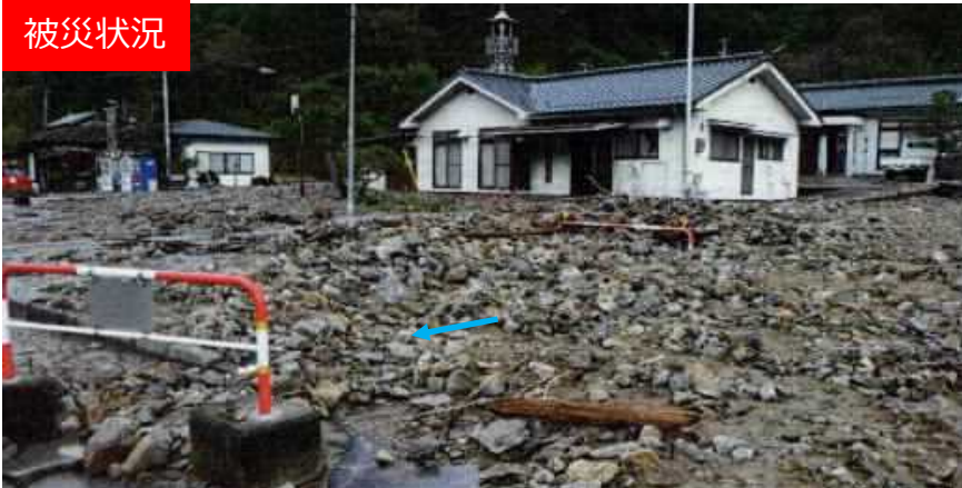
不安定土砂堆積状況
