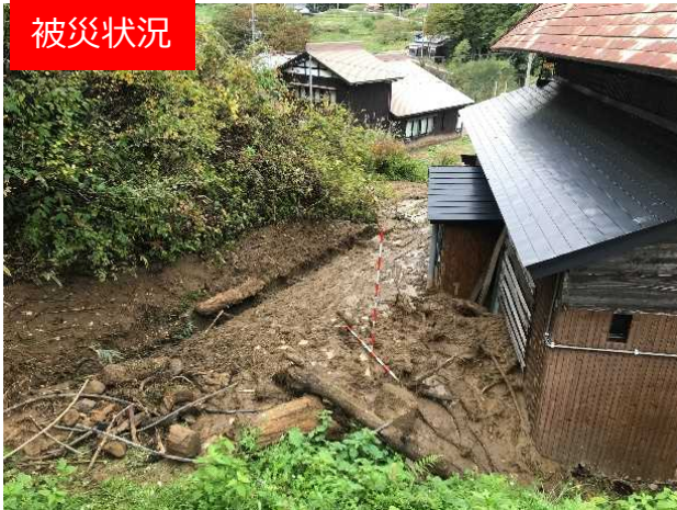
不安定土砂堆積状況
