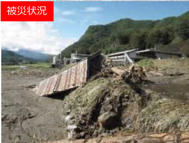
不安定土砂堆積状況
