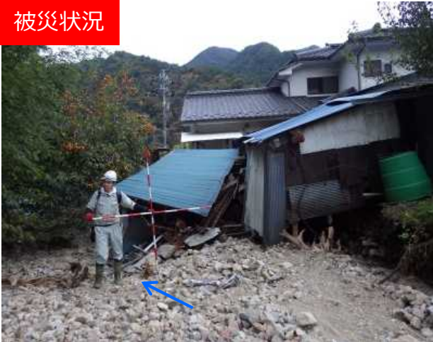
不安定土砂堆積状況
