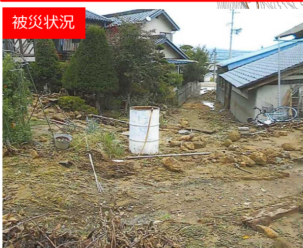
不安定土砂堆積状況
