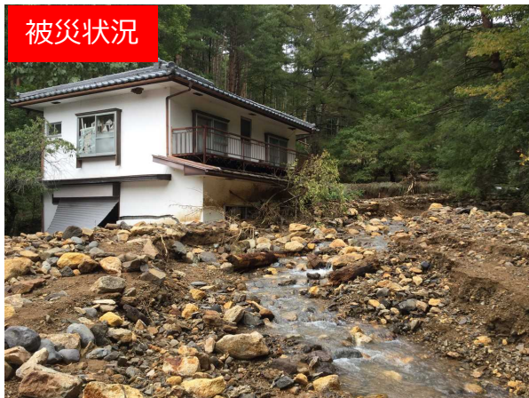
不安定土砂堆積状況
