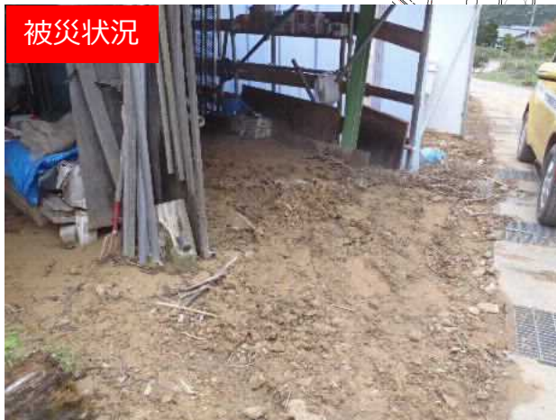
不安定土砂堆積状況
