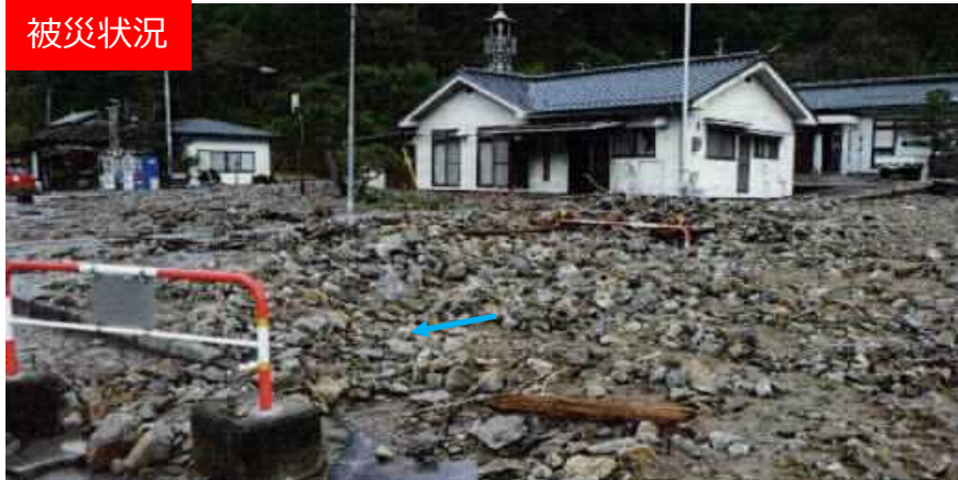
不安定土砂堆積状況
