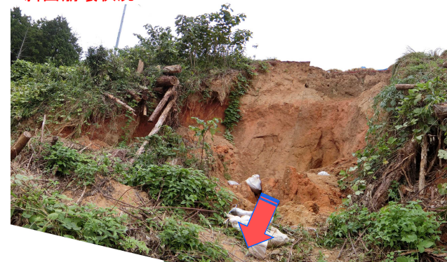
斜面崩壊状況
